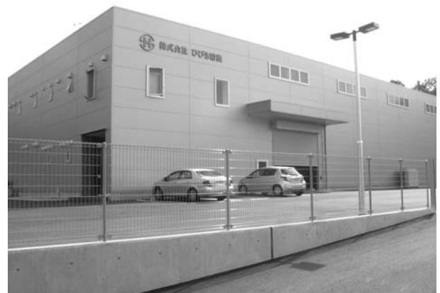
▲4月に完成した新工場
