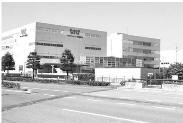
▲松山工場全景
