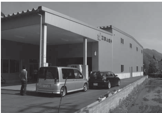
▲第二工場全景
